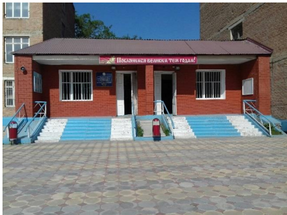
главный учебный корпус -
